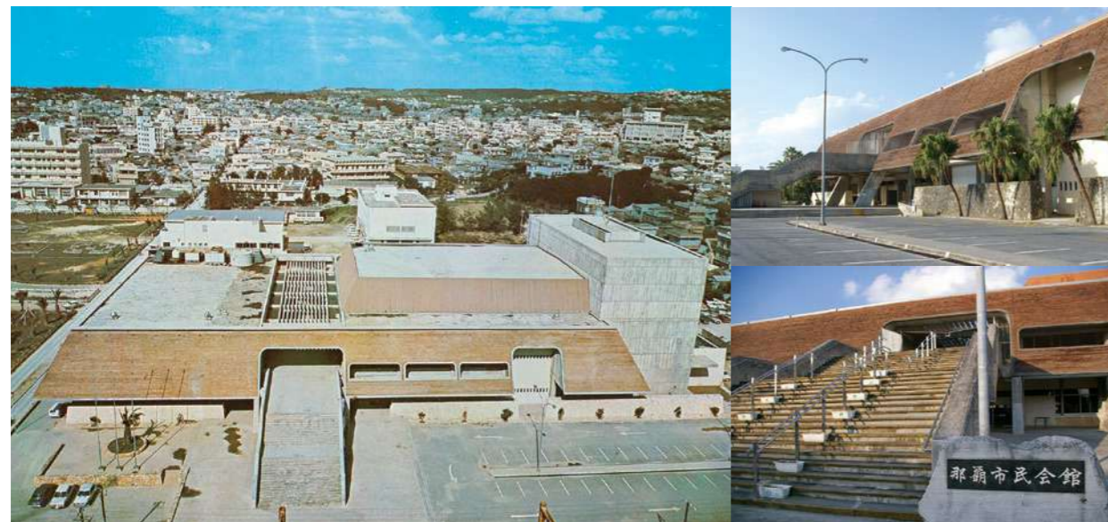
沖縄の伝統的建築物の要素を現代建築に取り込んだ意匠。 屋根の赤瓦、大きく張り出した屋根によるアマハジ、外部とロビーに配置されたひんぷん。
