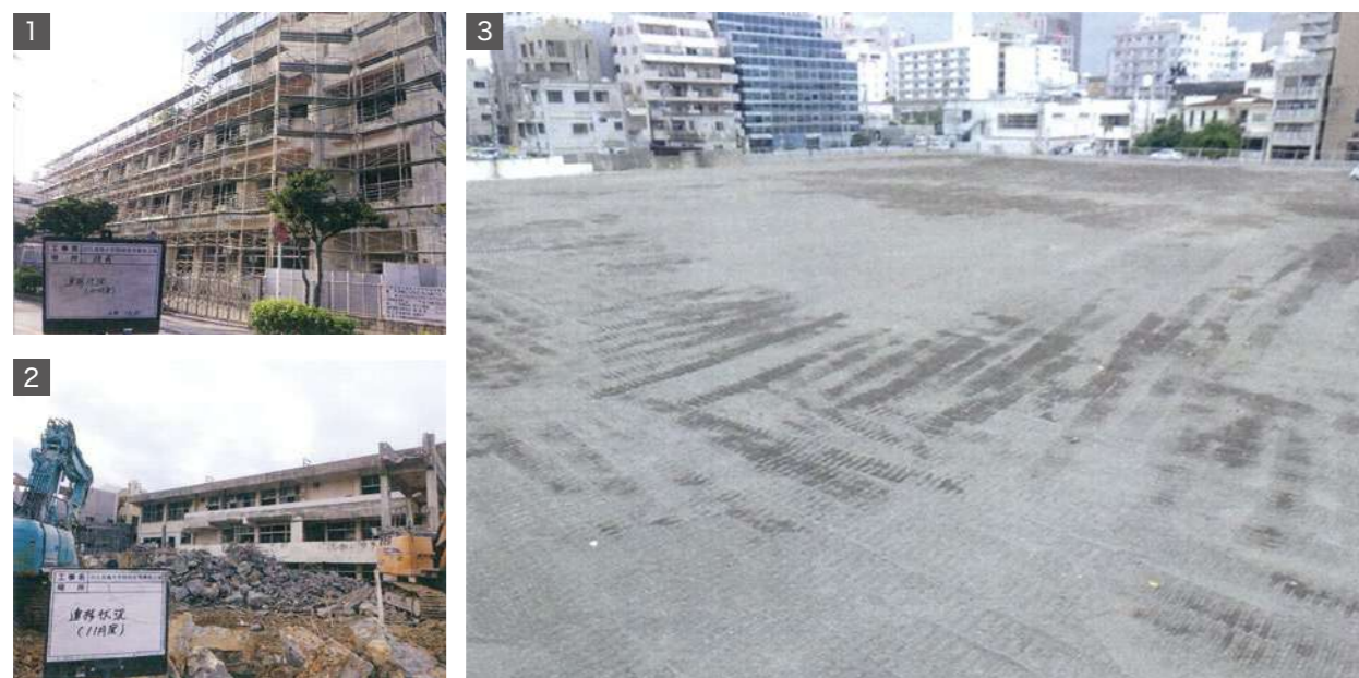
解体工事状況
